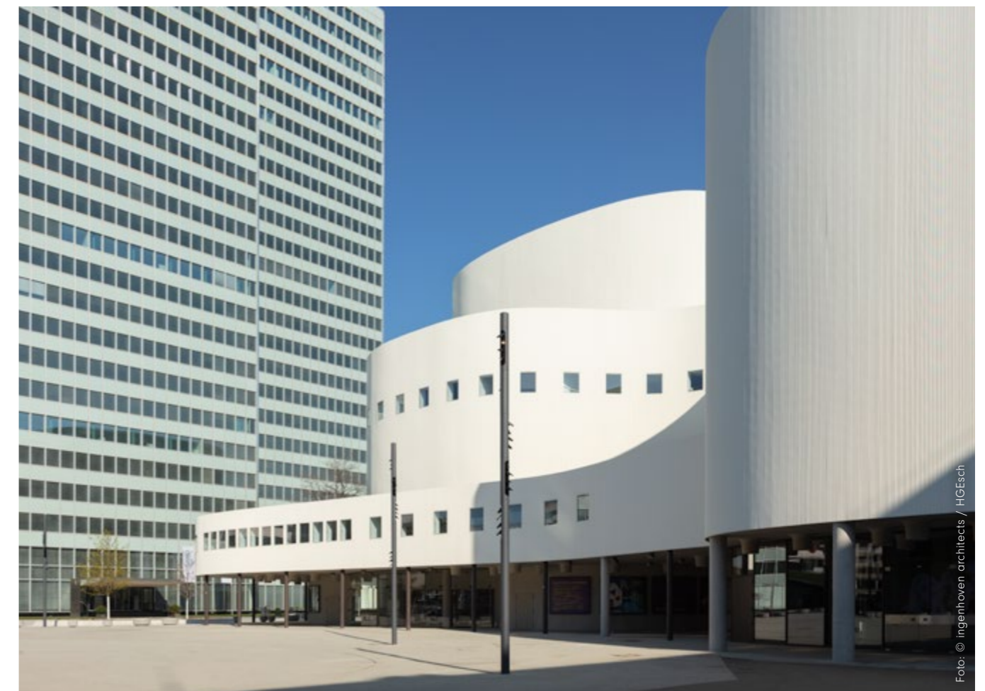
Mit zurückhaltender Ästhetik findet auch am Tag der Transfer von der Bühnenbeleuchtung zum gestalterischen Gesamtkonzept des Platzes statt.
