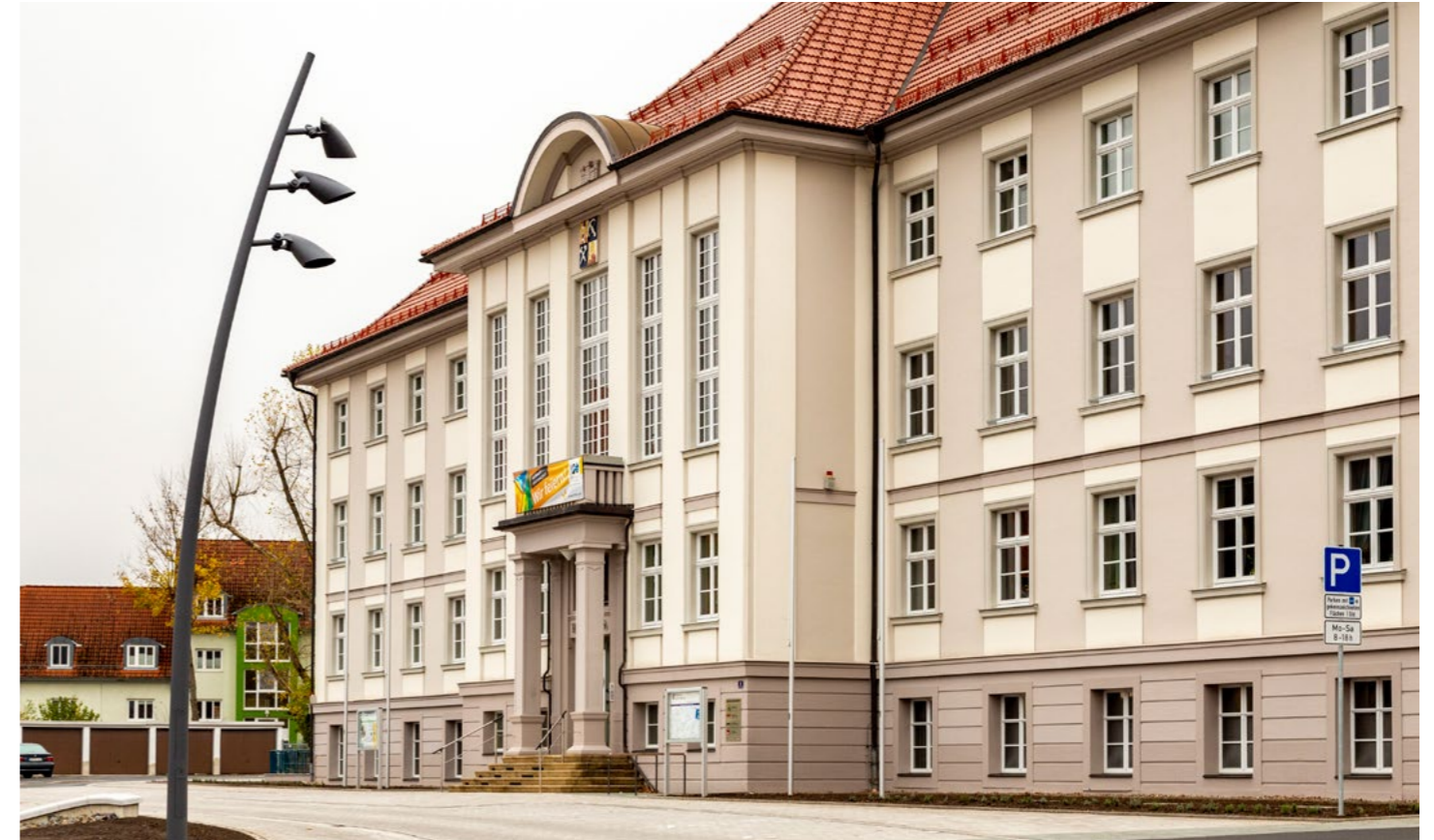
Tous les luminaires ARINI ont été peints en couleur DB 703. Une couleur qui s'harmonise très bien avec les couleurs choisies pour les matériaux utilisés sur la place ainsi que les couleurs choisies pour la façade de la mairie.
